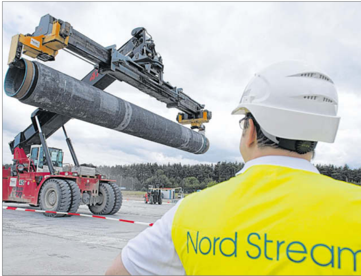
Eine Szene aus dem Jahr 2012: In Lubmin wird die Nord-Stream-Pipeline gebaut.
